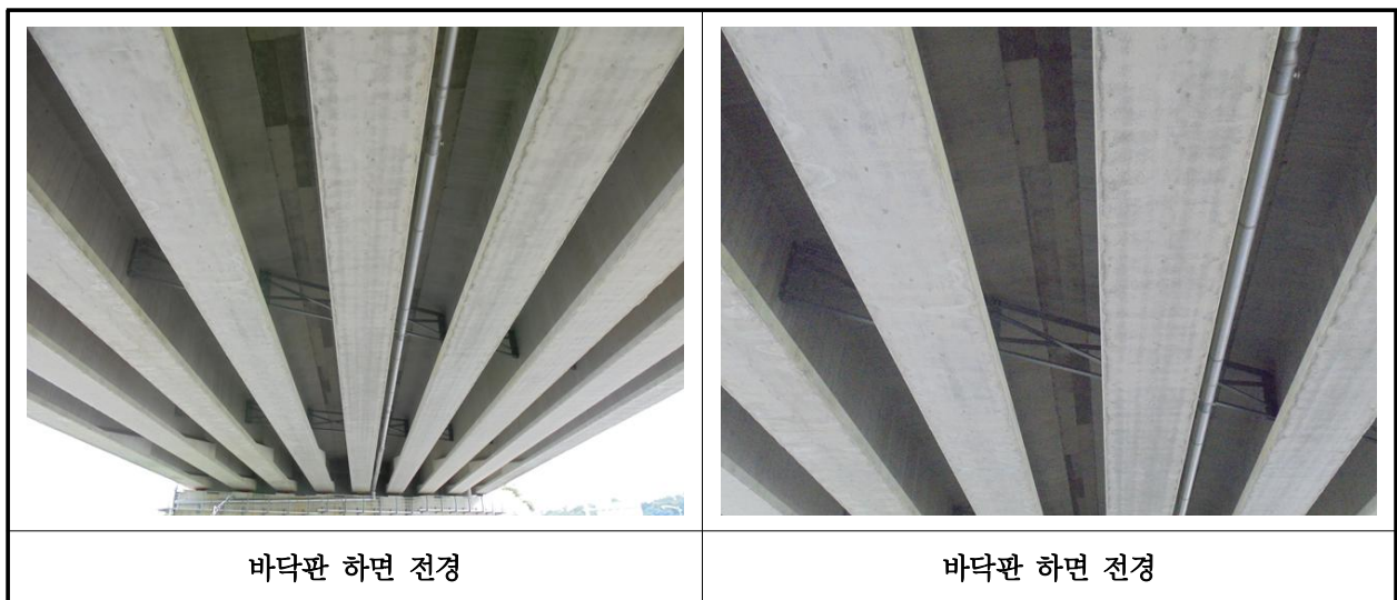
【사진 33.3.2】 바닥판하면 전경
