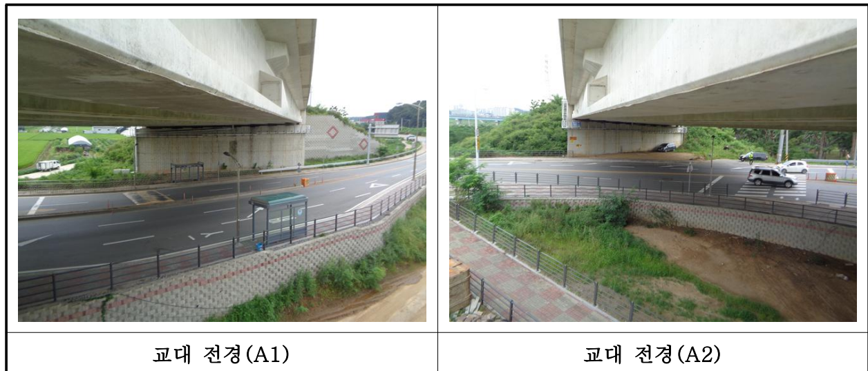
【사진 33.3.8】 교대 전경
