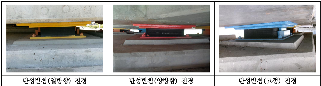
【사진 33.3.12】 교량받침 전경
