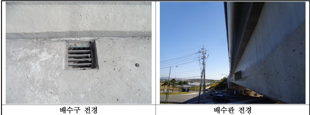
【사진 33.3.21】 배수시설 전경
