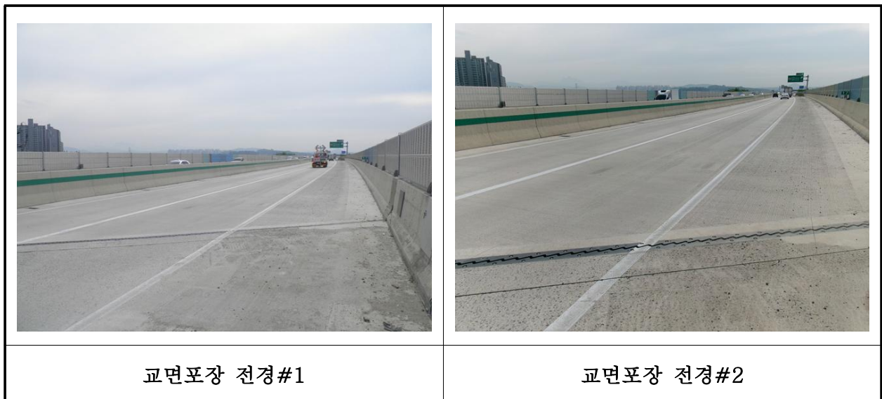
【사진 33.3.19】 교면포장 전경
