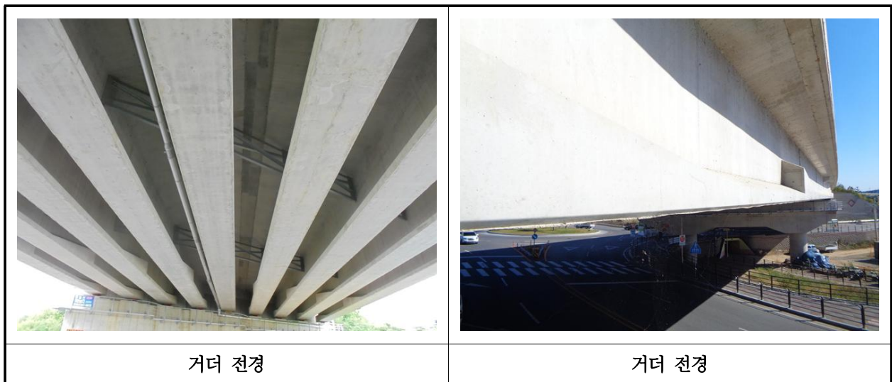
【사진 33.3.4】 거더 전경
