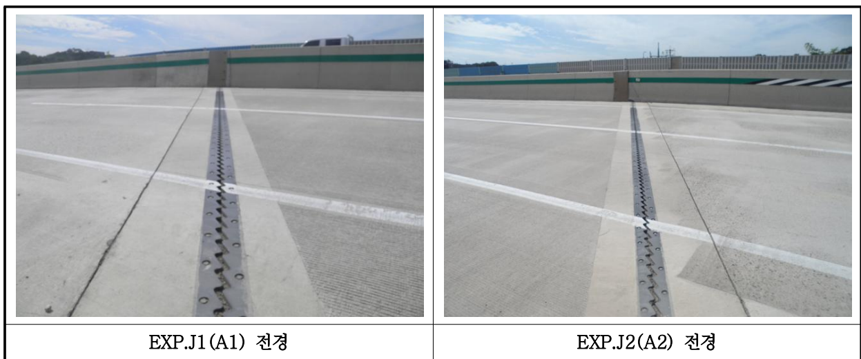
【사진 33.3.16】 신축이음장치 전경
