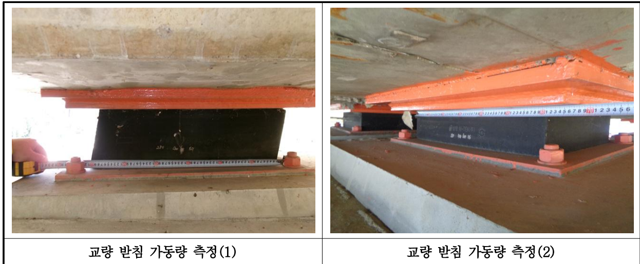
【사진 33.3.15】 교량받침 이동량 측정
