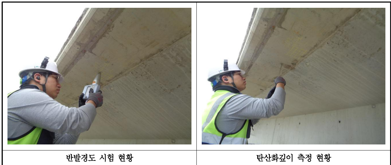
【사진 33.4.1】 콘크리트 내구성조사 현황
