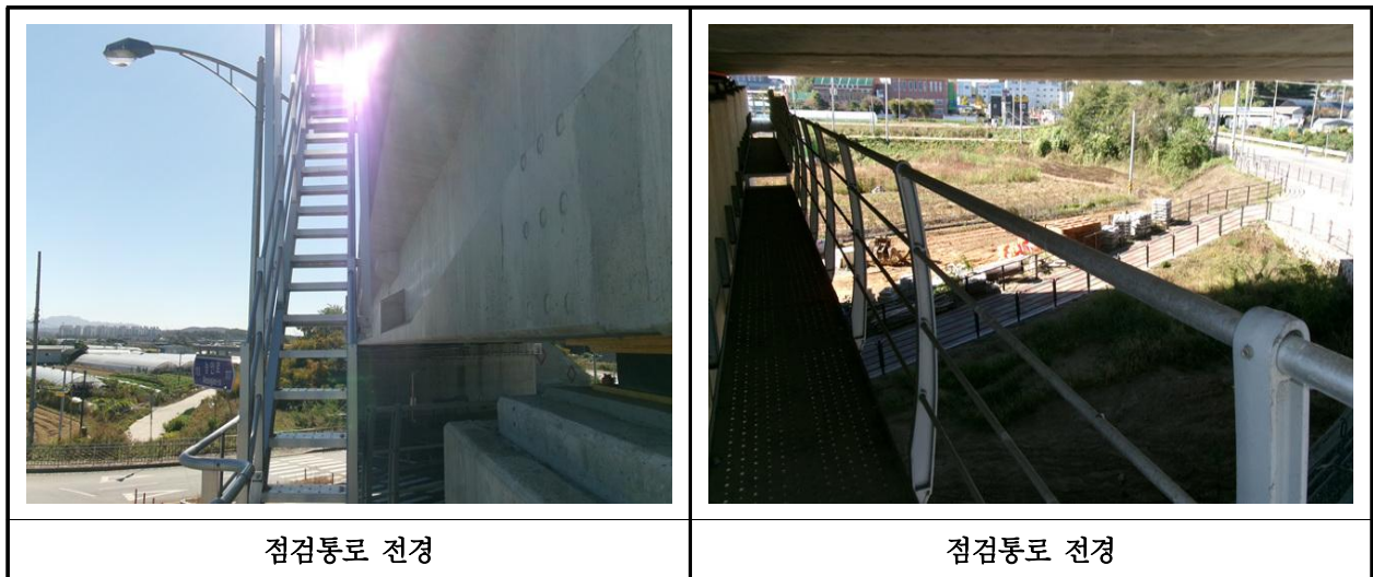
【사진 33.3.25】 교량 점검시설 전경
